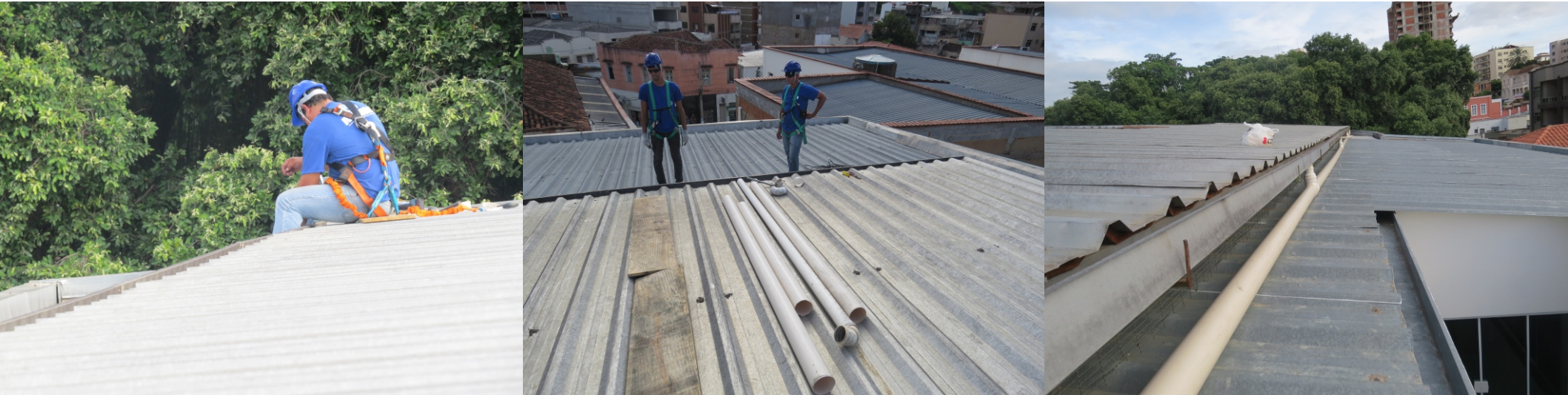
Técnicos substituindo a tubulação e encaixando novos canos no telhado da Câmara Municipal de Visconde do Rio Branco
