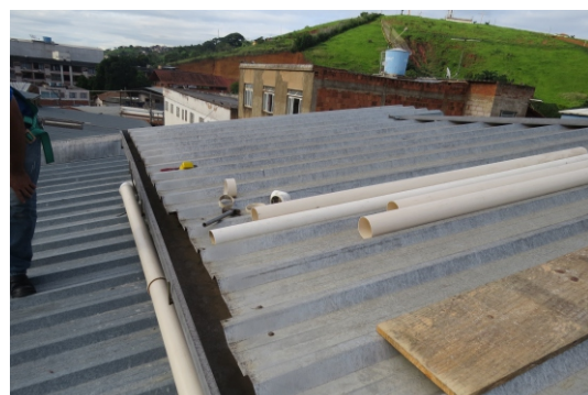
Técnicos trocando tubulação da Câmara
